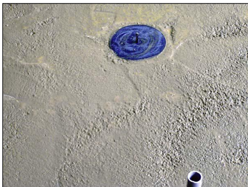
(a) Badan silinder perangkap lantai yang dipasang pada papak lantai dengan penutup.
