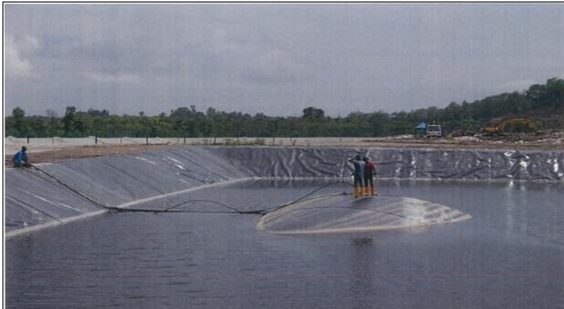
Rajah 8.2 Kolam pengumpulan air larut resap
