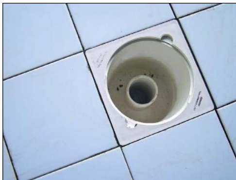
(b) Penutup perangkap lantai ditanggalkan selepas jubin dipasang. Perhatikan pengedap air di dalamnya.
