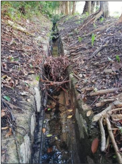
Rajah 3.2 Air bertakung di dalam parit yang tersumbat akibat daun gugur
