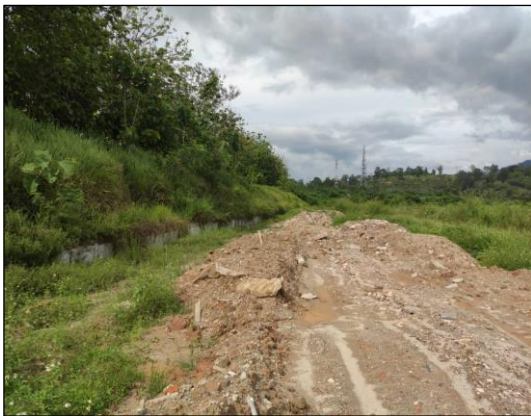
Penimbusan tidak sekata dengan genangan air
