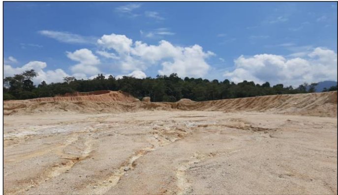
Gegeluk semasa kerja tanah
