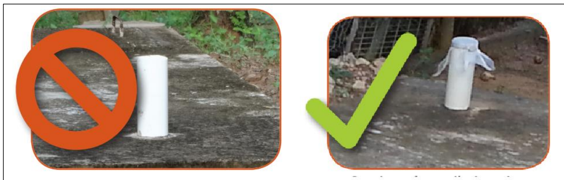
Rajah 5.11 Paip bolong yang terdedah hendaklah ditutup dengan sempurna menggunakan skrin jejaring (Sumber: Jabatan Kesihatan dan Perkhidmatan Manusia–Amerika Syarikat)
