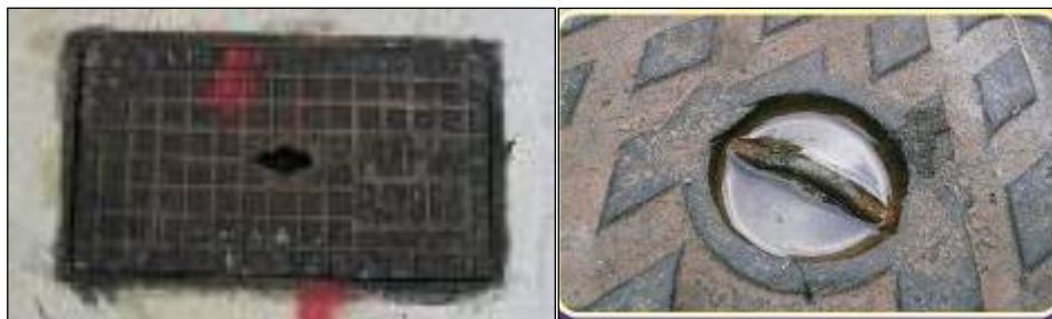
Rajah 5.10 Lubang kunci atau cangkuk pengangkat untuk penutup lurang atau ruang pemeriksaan boleh menyebabkan air bergenang
