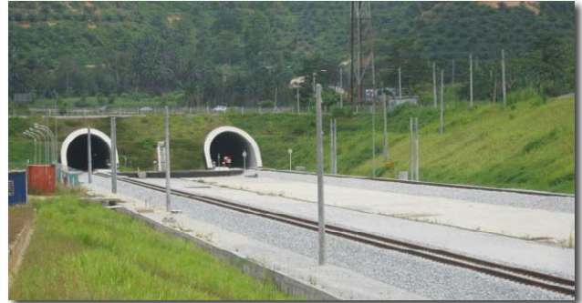
Bukit Berapit Rail Tunnel
