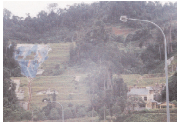
Profil luluhawa tropika jasad batuan granit kelihatan pada cerun keratan di Bukit Tinggi, Pahang
